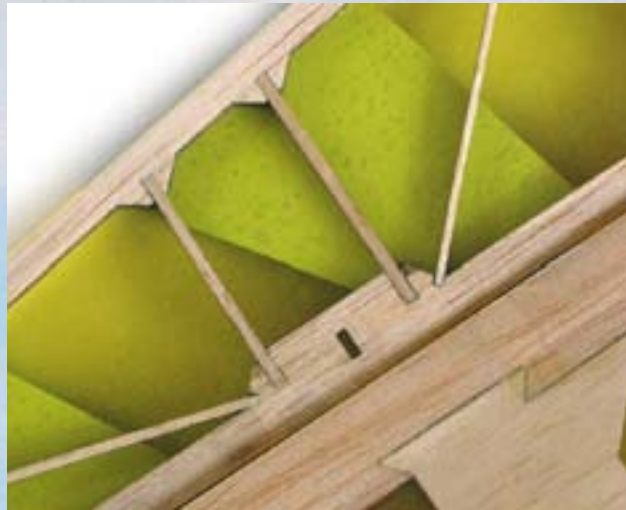
Die einzelnen Teil von sind präzise ausgeschnitten und miteinander verzapft. Ohne CNC Technik kann man gar nicht so bauen.
