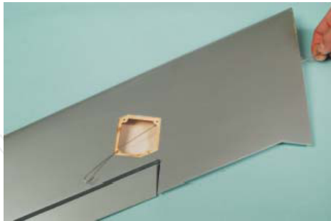
Kabel mit dünnem Stahldraht durchziehen
